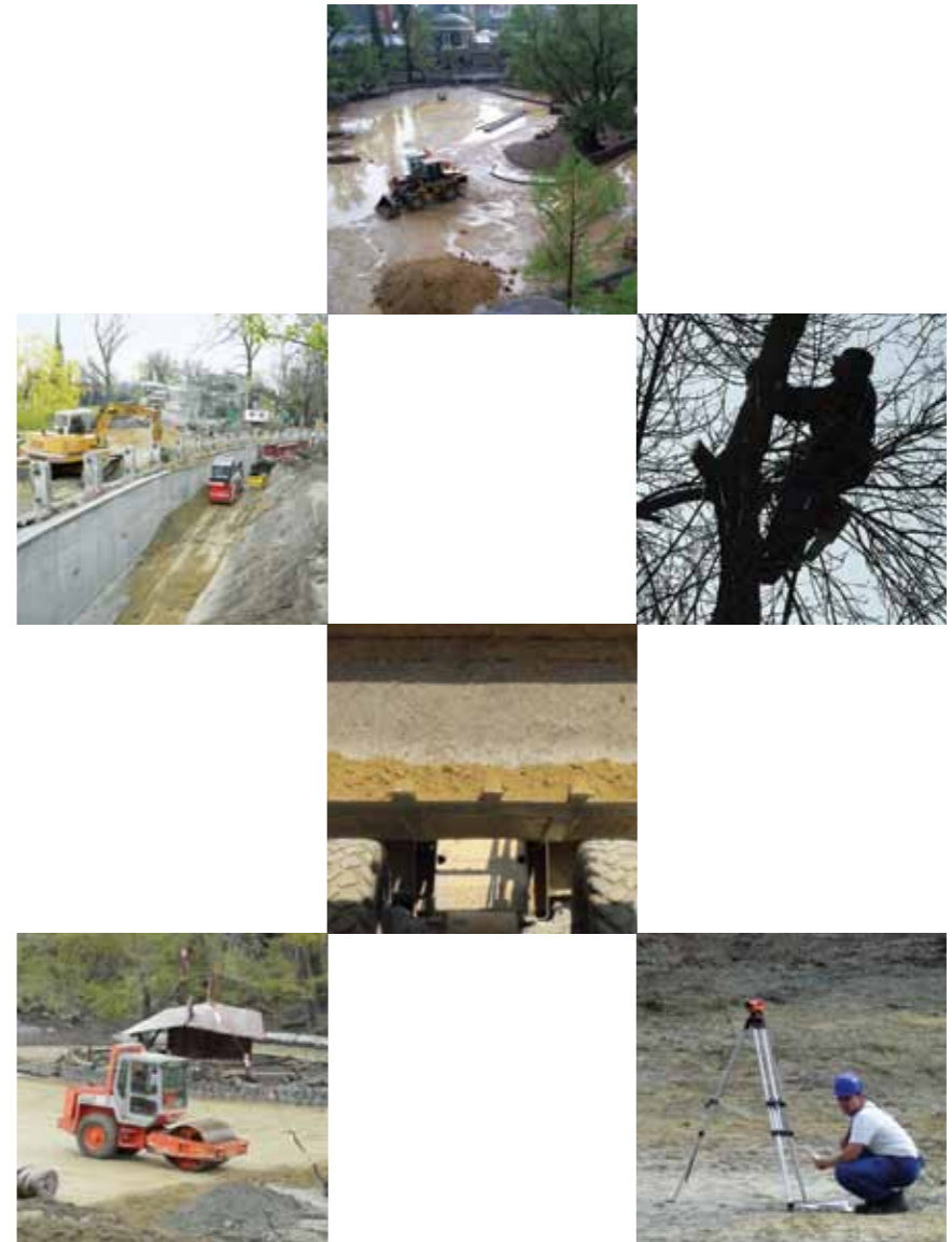
A Nagytavat teljesen újjáépítették: kimélyítették és új vízzáró agygréteget terítettek a mederbe, a tóparton futó sétány támfalát megerősítették ↓ The Great Lake was completely rebuilt: the bed of the lake was deepened and it received a new impermeable clay layer at the bottom, the wall along the path at the lakeside got supported. ↓ Der Großsee wurde vollkommen umgebaut und neugestaltet: sein Bett wurde vertieft und mit einer neuen, wasserabschließenden Lehmschicht versehen; die Stützmauer der am See entlang-führenden Promenade wurde verstärkt
